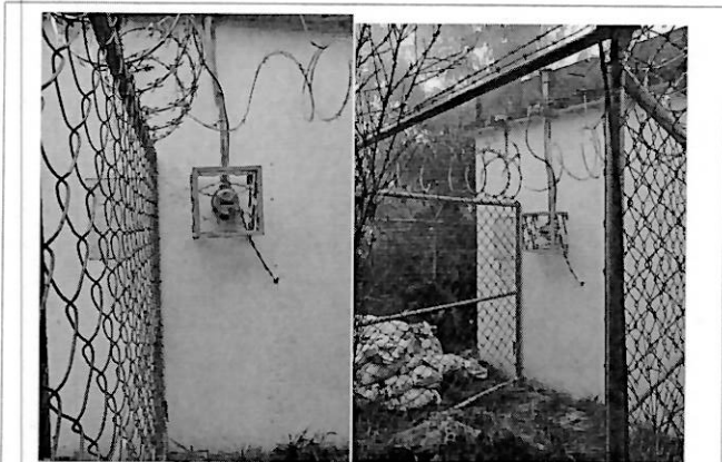
Se deja concluida la modificación de la reja como pasillo para el acceso externo del personal de la CFE
